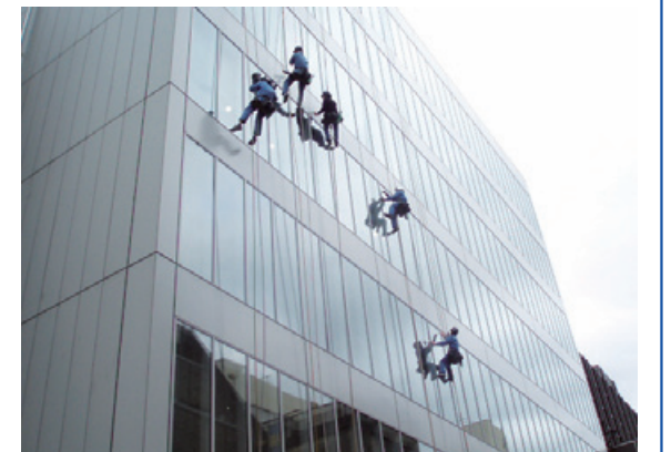
高所清掃作業 (ブランコ作業)
